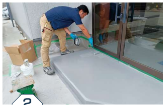
フレークベース塗布 (標準2回塗り)
