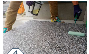
フレークトップ塗布 (標準2回塗り) ※高防滑仕様もあり
