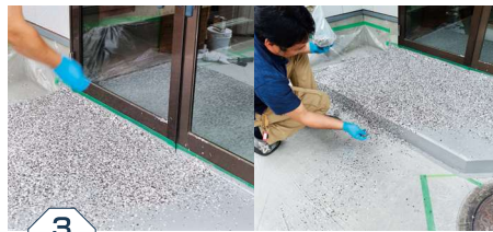
ブレンドフレーク散布 (立面は叩きつけながらの散布)
