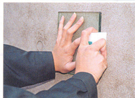
写真-5 現場での測定状況
