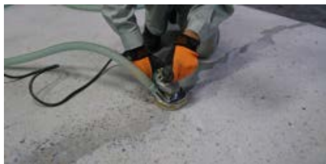
コンクリートの表面磨き
