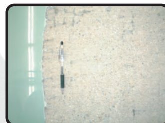
6Pカッターブレード使用
