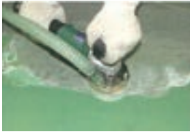
●エポキシ塗膜の除去
