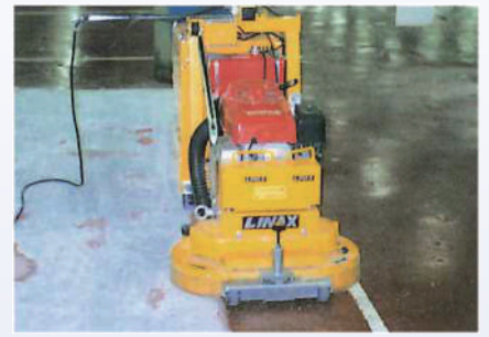
■エポキシ塗膜の除去
