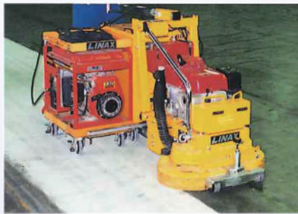
■強化コンクリートの目荒し
