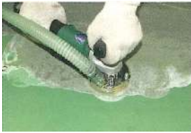
●エポキシ塗膜の除去
